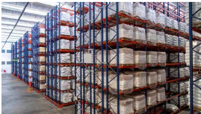
Centro de Distribuição Química Carioca – Garuva-SC
